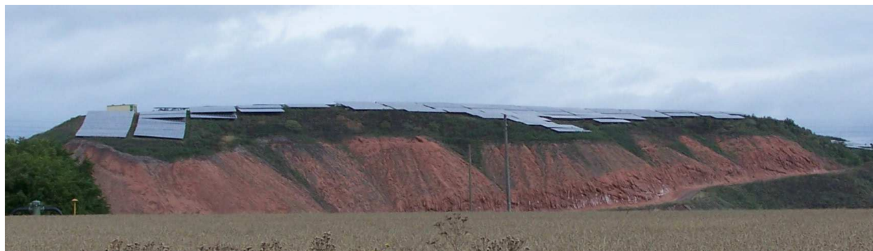
PV-Freiflächenanlage auf der Kalihalde Bleicherode (Foto: Steffi Gross, 2011).
